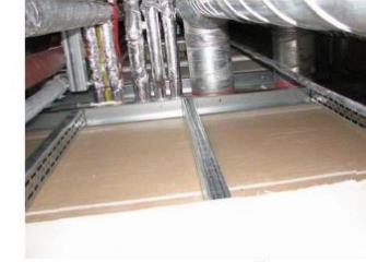
Abbildung 30: Schachtwand, 2x12,5mm, Innenseite
