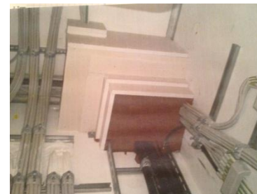
Abbildung 40: Überbelegte Kabeldurchführung in Massivdecke
